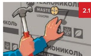
**2. Крепление теплоизоляции.** Прикрепите плиты LOGICPIR Балкон при помощи пластиковых фасадных дюбелей из расчета 2 шт. на 1 плиту. Либо приклейте их с помощью монтажной пены.
