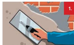
**1. Подготовка основания стены.** Подготовьте поверхность стен, удалив старую осыпавшуюся штукатурку, гвозди, торчащие концы арматуры и другие дефекты и неровности. При необходимости стену оштукатурьте.
