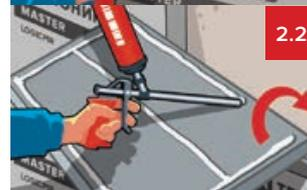
**3. Создание паронепроницаемого слоя.** Проклейте стыки плит алюминиевой лентой, чтобы получить герметичный паронепроницаемый слой, надежно предохраняющий стену от увлажнения. Благодаря фольгированной обкладке утеплителя LOGICPIR Балкон можно полностью отказаться от пароизоляционного слоя.
